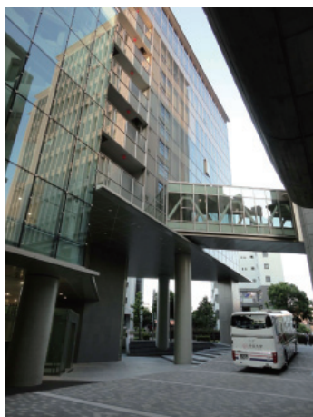
1号館（講義棟・図書館）
